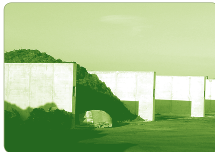
› Vue sur des silos de fermentations.
