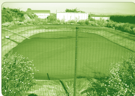
› Bassin de récupération des eaux de ruissellement colonisé par des lentilles d'eau.
