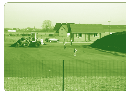
› Vue sur un local technique de type « chalet ».
